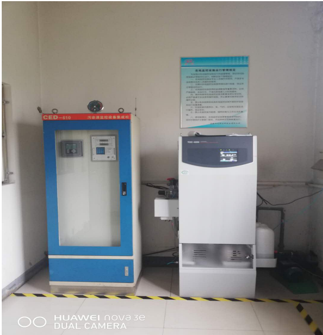
污水在线监控设施▲
