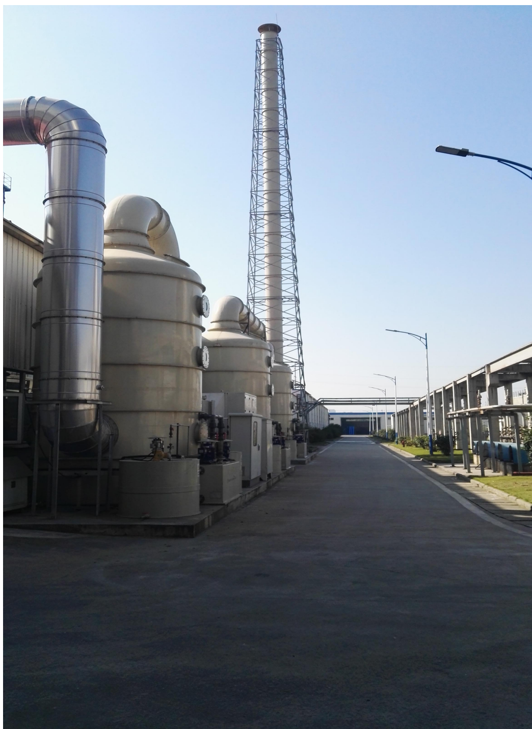
无组织废气收集治理设施▲
