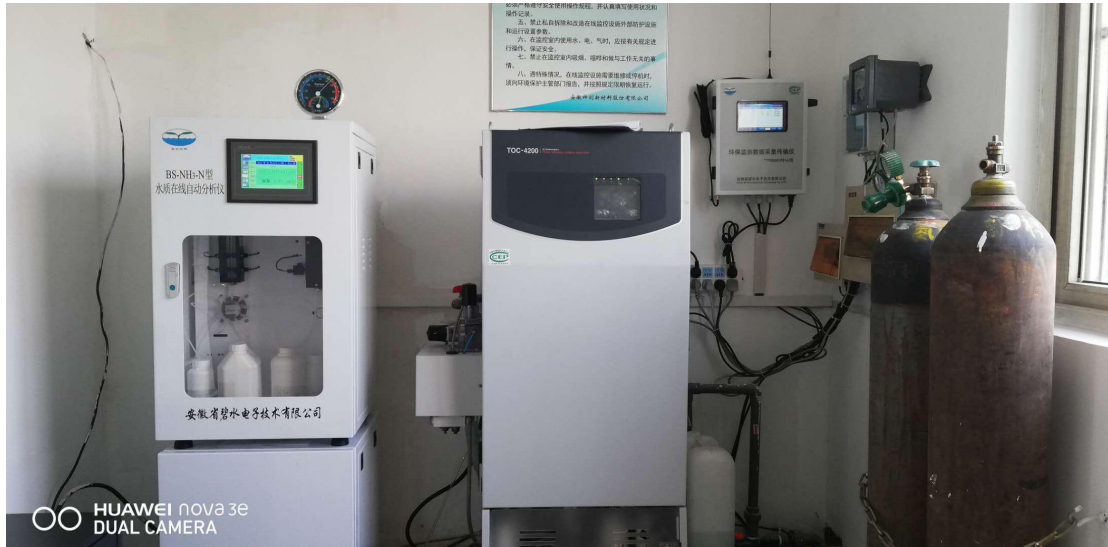
污水在线监控设施▲
